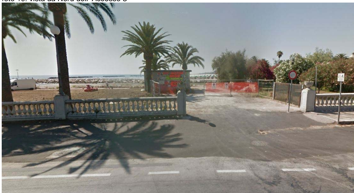
foto 10: vista da Nord dell' Accesso 5
