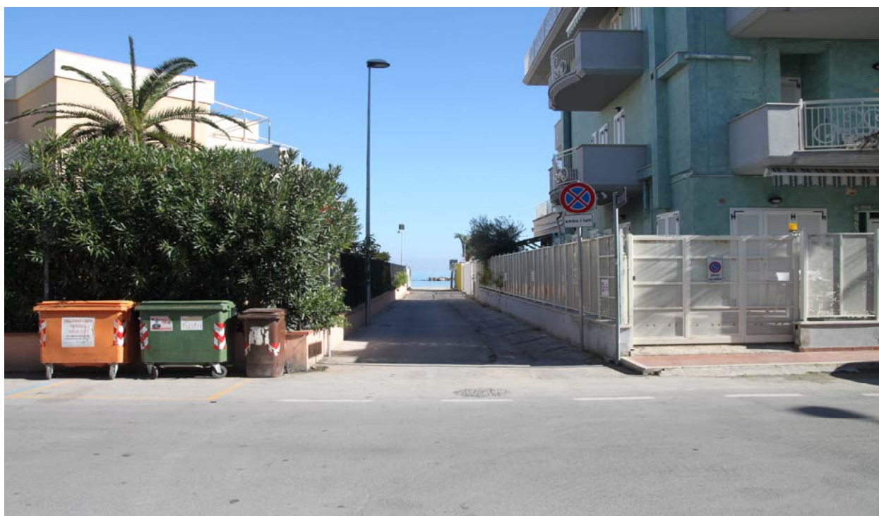
foto 26: vista da Ovest dell' Accesso 13
